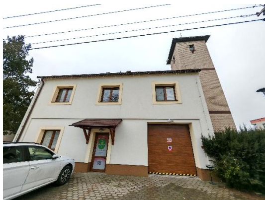
Obr. č. 14 – Hasičská zbrojnice
