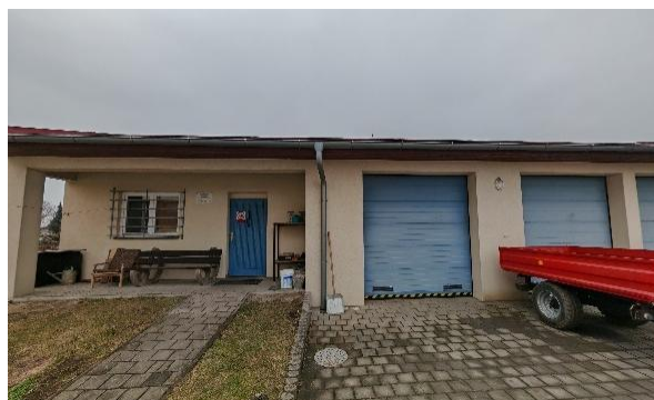
Obr. č. 43 – Hospodářská budova
