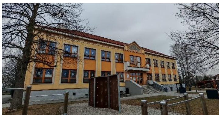
Obr. č. 40 – Základní a mateřská škola
