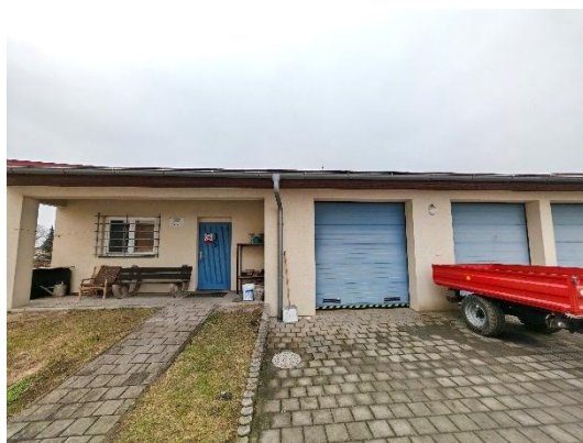
Obr. č. 15 – Hospodářská budova
