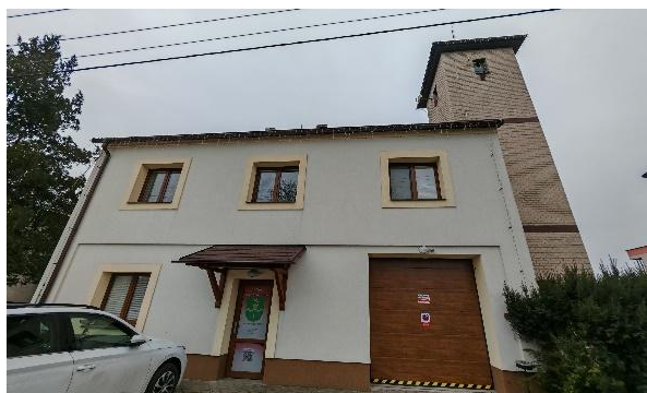
Obr. č. 42 – Hasičská zbrojnice
