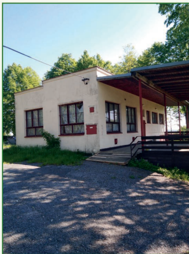
PŮVODNÍ STAV SPOLKOVÉHO DOMU
